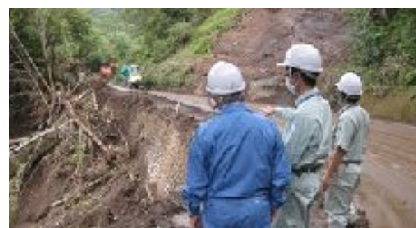
ハヶ岳高原ライン災害復旧（県道北杜富士見線）
